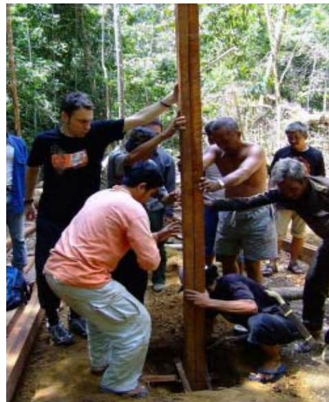
Penancapan tiang pertama Camp Lubuk Baji
